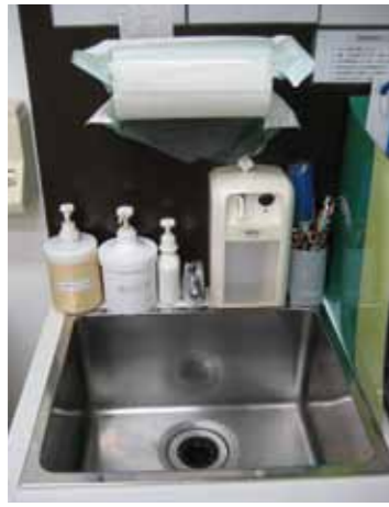
図4 自動水栓、ディスペンサー、滅菌ペーパータオルが設置された手洗いシンク
